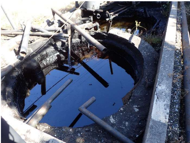
図10 C3号ろ過池
